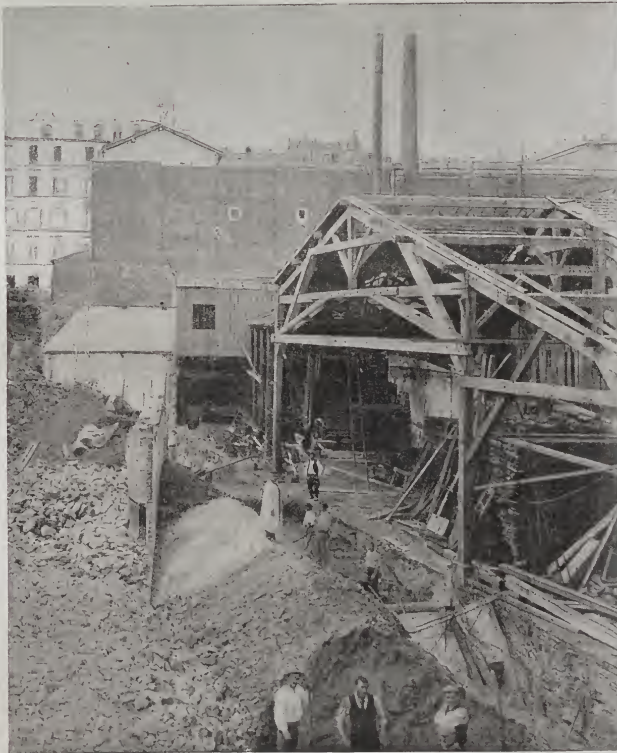
LA LIGNE COURCELLES-CHAMP-DE-MARS. Tranchée au débouché du souterrain vers la Seine.
